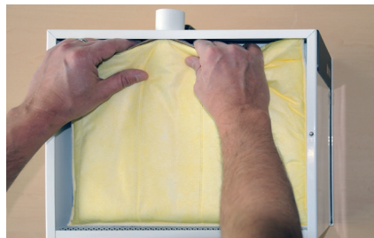
2 Filterbeutel wieder einsetzen
